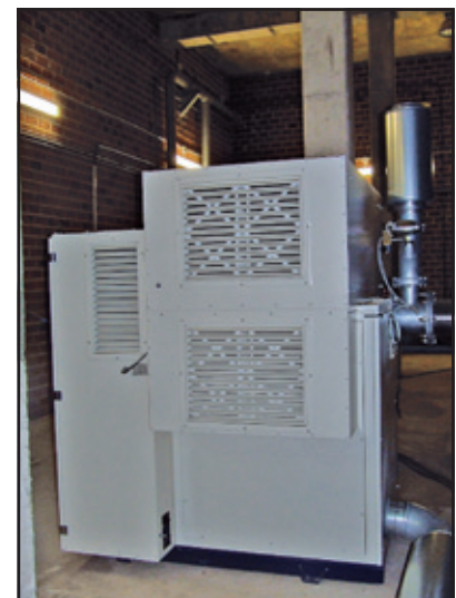
Figura 5. Turbocompresor con sistema de levitación magnético.
