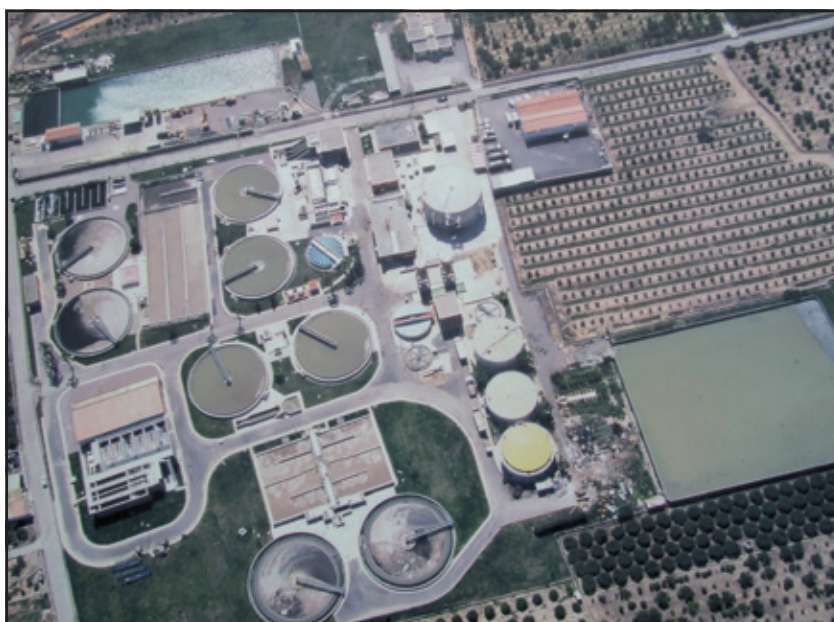
Figura 2. Vista aérea de la EDAR de Castellón.
