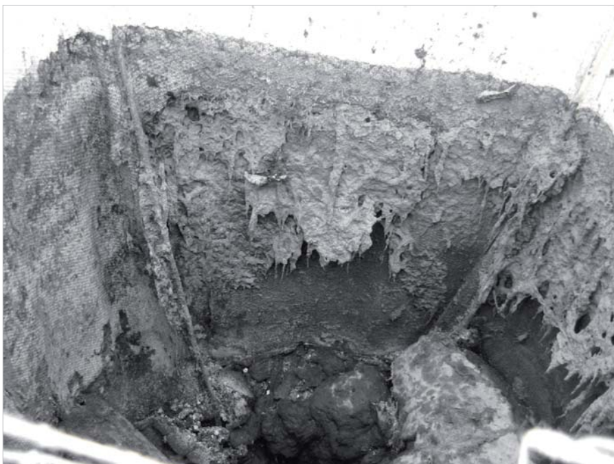
Figura 4. Paquetes de membranas planas con un acusado problema de clogging ocasionado por fibras y pelos. En la foto contigua, residuo de rechazo del sistema de filtración recogido en un Big-Bag.
