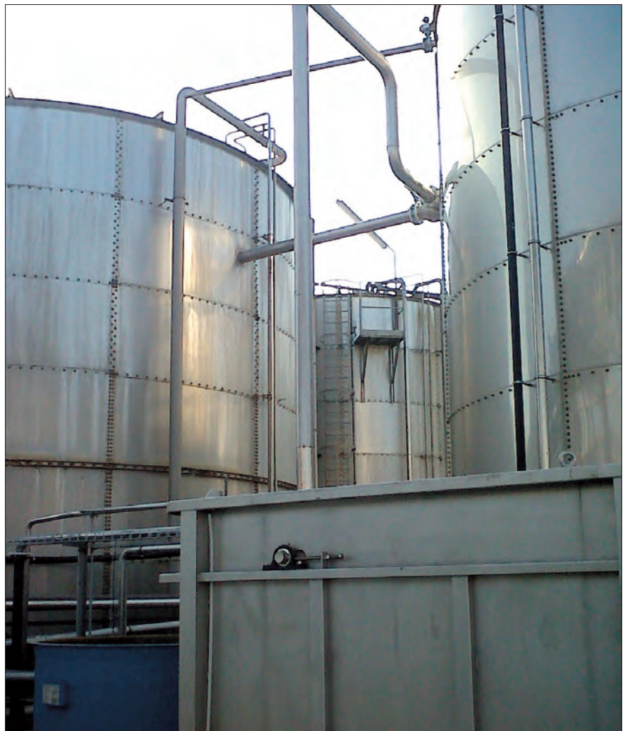
Figura 5. Vista de los reactores
