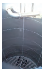
Figura 2. Aspecto interior de un reactor de tipo MBBR
