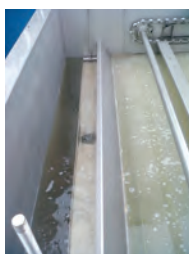
Figura 7. Detalle del clarificado final en la salida del DAF
