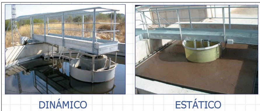
Figura 4: Tipos de decantación secundaria
