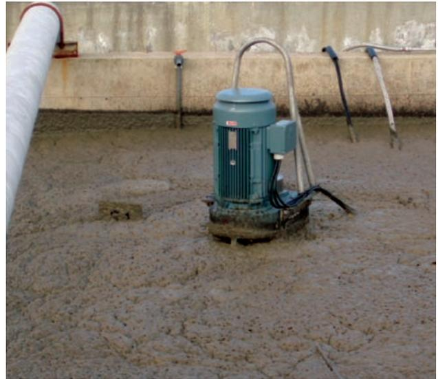
Figura 3. Situación inicial, detalle del Turboxal colocado en la superficie del reactor biológico de la línea 1.
