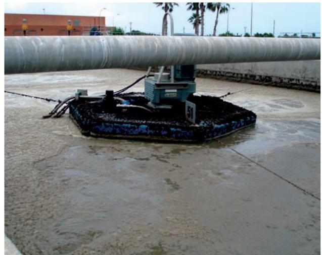
Figura 5. Resultados obtenidos. Detalle del Turboxal colocado en la superficie del reactor biológico de la línea 1.
